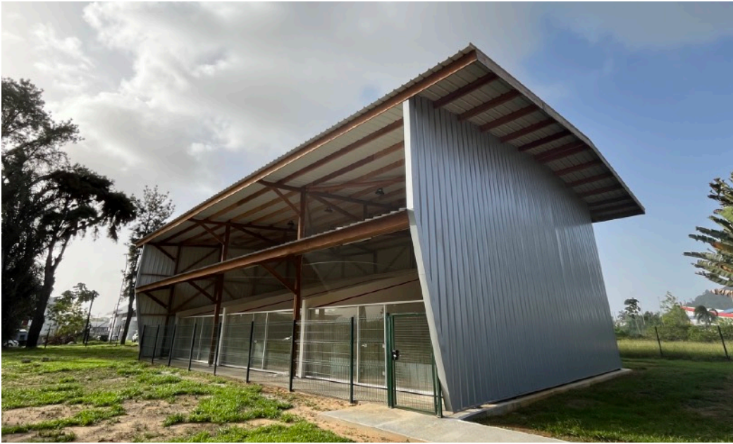
PHOTO EXTERIEURE DU BATIMENT
