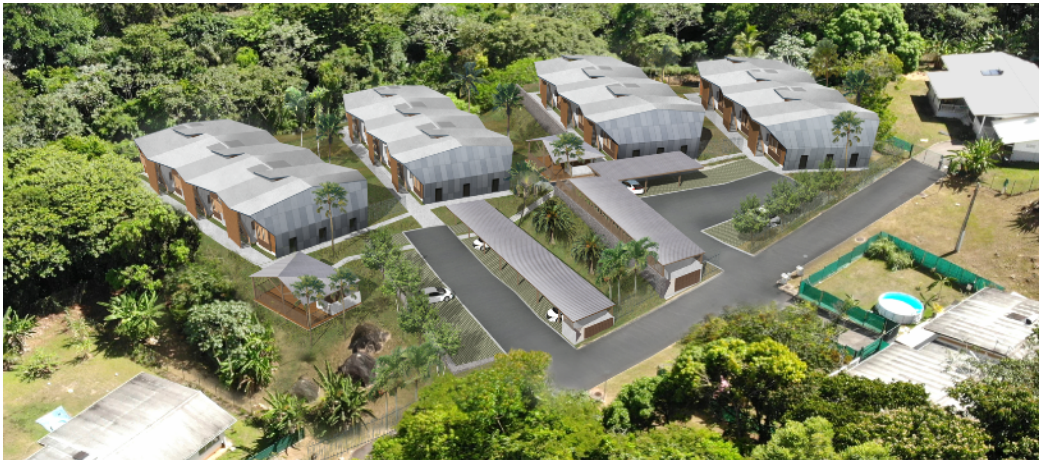
VUE AERIEENNE DE L'OPERATION
